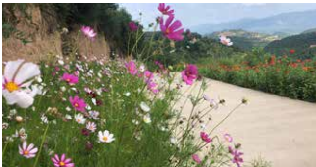
成县纸坊镇庙下村农村公路
