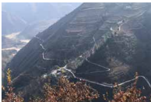
成县索池镇安塆村农村公路
