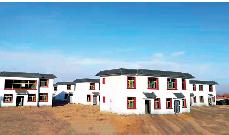
2021 年西洞镇滚坝村农房改造示范点
