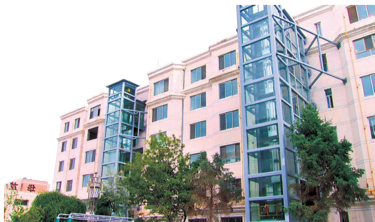
老旧楼院改造加装电梯
