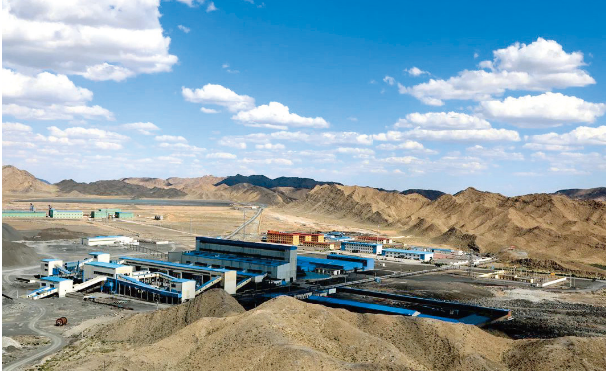
肃北县博伦矿业开发有限公司厂区。
