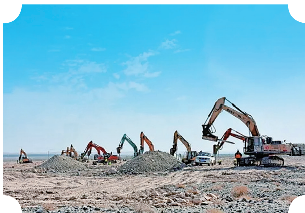
陆泰 200 兆瓦光伏发电项目施工现场
