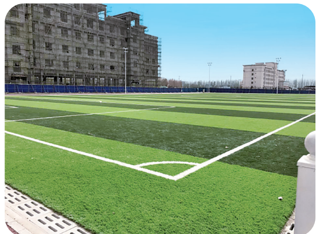
阿克塞县中学标准足球场建设项目完工
