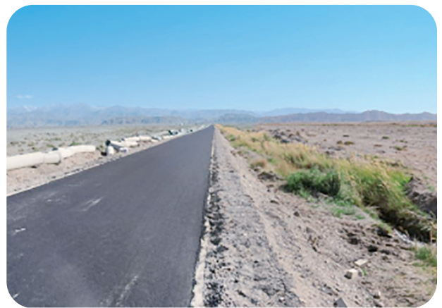
2021年新建22公里自然村组道路(青石沟自然村组道路段)
