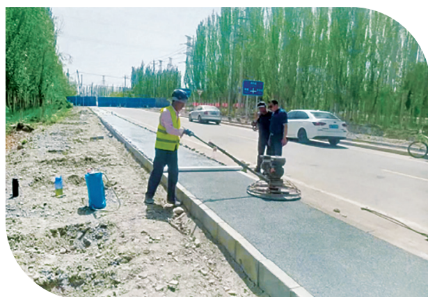
民族村健走步道项目正在建设
