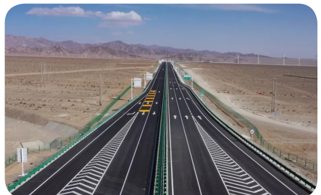
2020年9月，敦当高速四标当金山南段16公里路面工程施工完工（阿克塞县融媒体中心摄）
