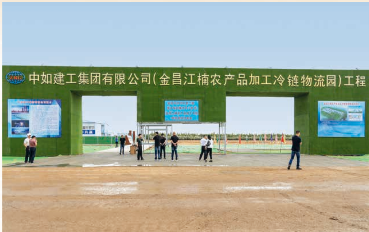
金昌·江楠农业科技开发有限公司农产品加工冷链物流园项目建设
