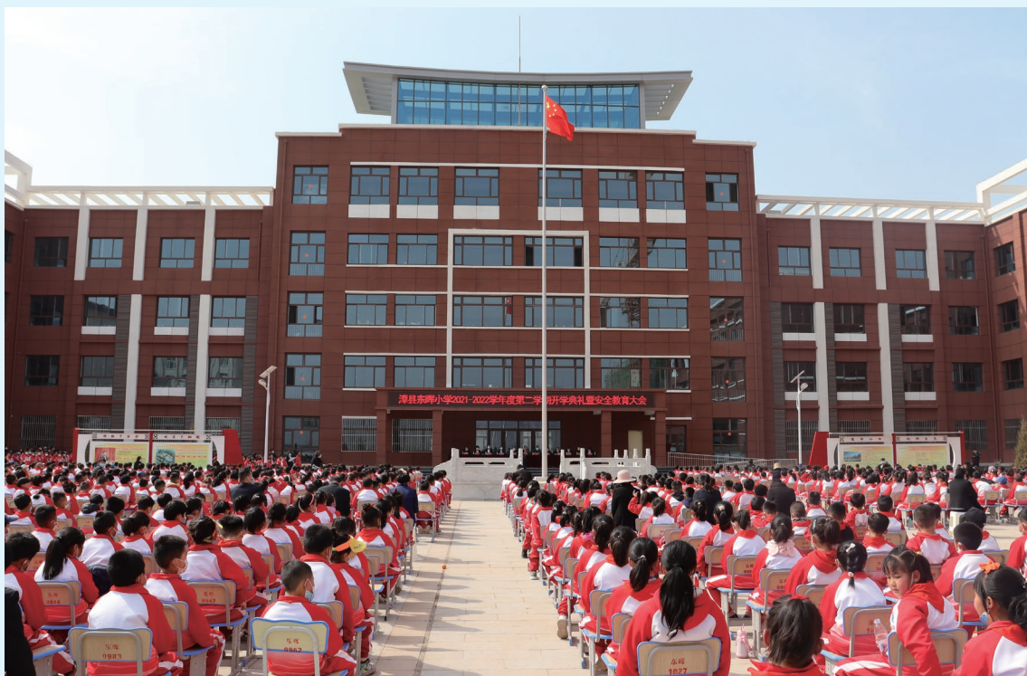
9月建成并投入使用的漳县东晖小学
