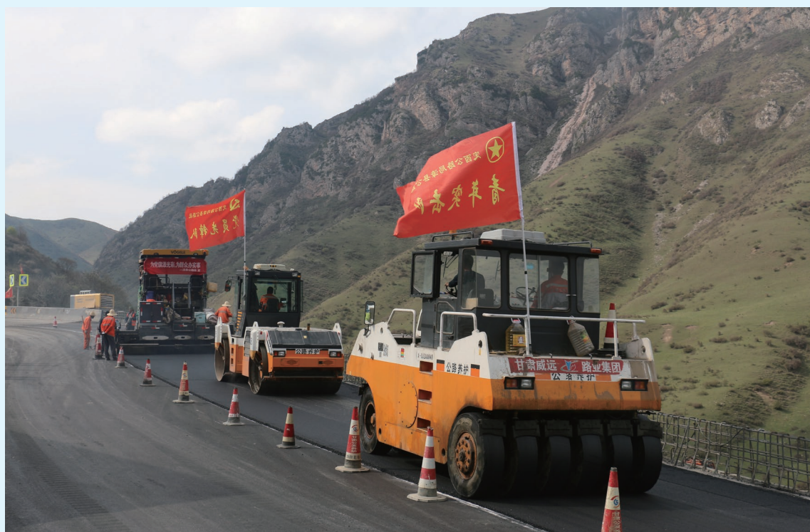
漳县公路段路面病害处置油路修补
