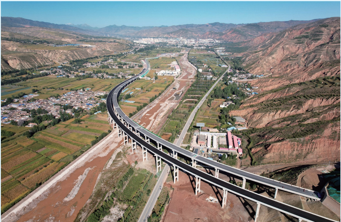
陇漳高速主体工程完工
