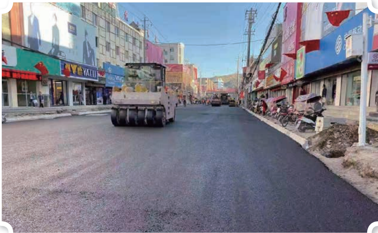
新民街道路铺油罩面
