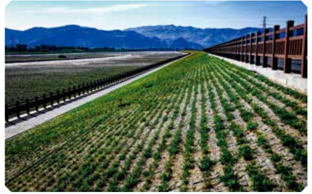
渭河生态综合治理工程（陇西段）
