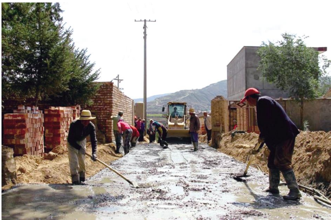
安定区鲁家沟镇将台村道路硬化工程进行得热火朝天
