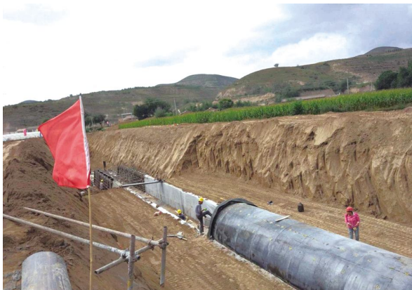
建设中的鲁家沟镇小岔沟排洪工程
