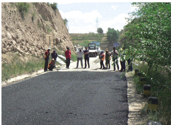
王定路 K20+400-K27+100 段进行铺油罩面施工
