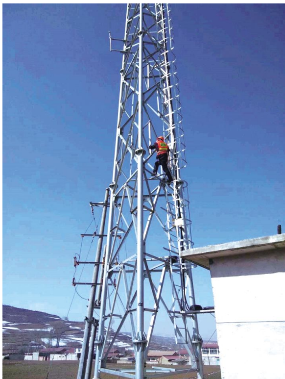
电信公司职工正在开展高空作业
