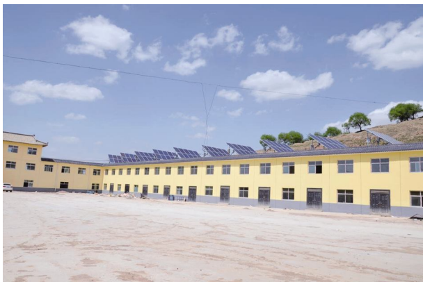
石泉村刘坪社 2016、2017、2018 年易地扶贫搬迁安置点 101 户,配套光伏发电项目 29 户
