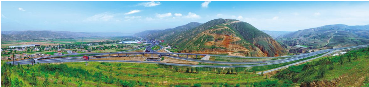
平(凉)定(西)、天(水)定(西)高速公路定西十八里铺互通立交
