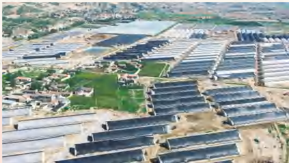
鲁家沟镇正在建设的定西现代丝路寒旱农业综合示范园区
