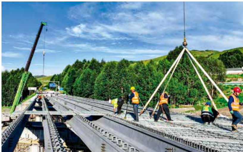
图101 2024年7月,国道312线安远河大桥 UHPC 轻工字梁架设 (武威公路事业发展中心 供图)
