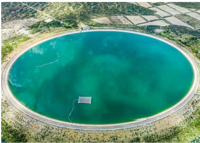
图 121 2024年6月,古浪县黄滩生态移民区5号调蓄水池
