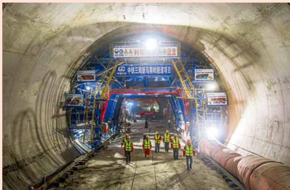
2021年，正在建设中的兰张高铁兰武段新乌鞘岭隧道
