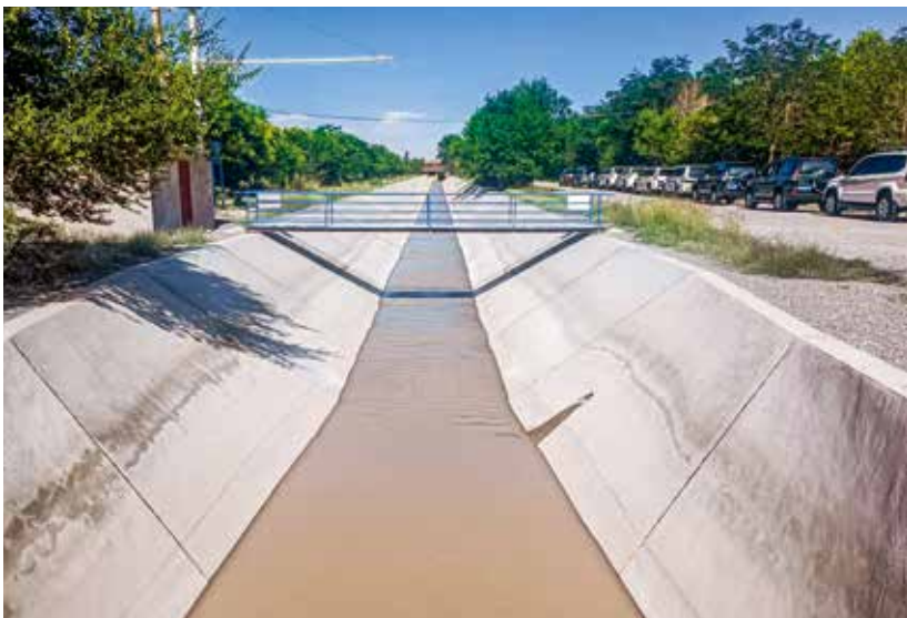
图 68 2024 年 7 月,凉州区金塔灌区续建配套与节水改造项目:改造后的总干渠 (市水务局 供图)
