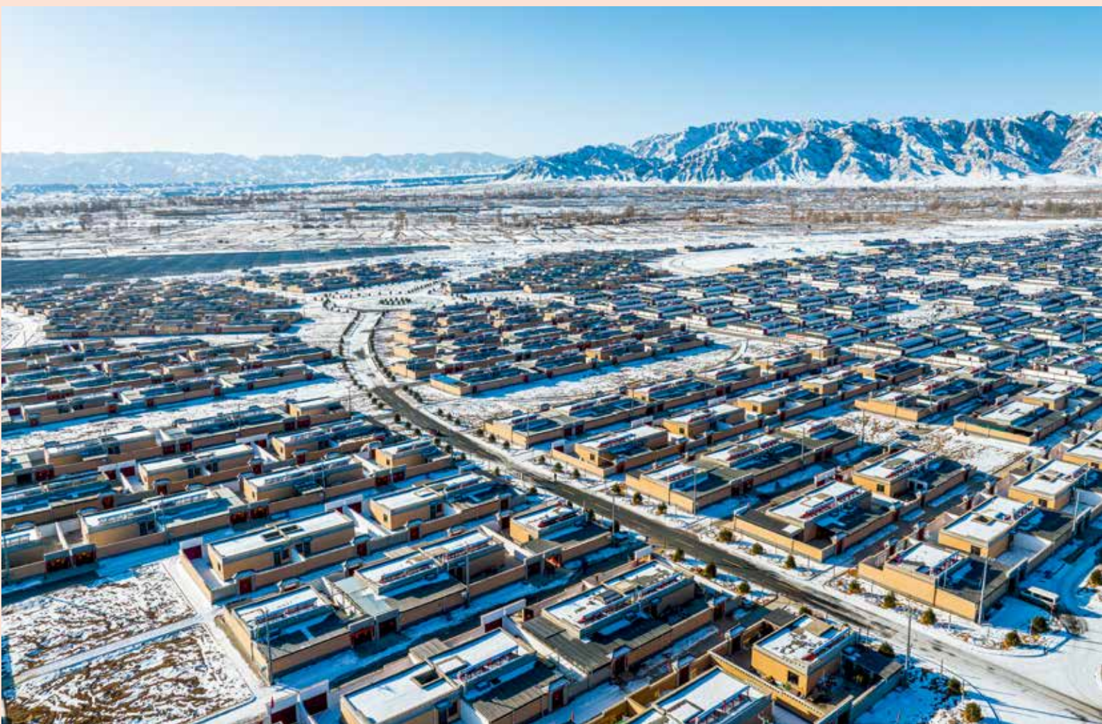
2024年2月,凉州区金山镇生态及地质灾害避险搬迁安置点
