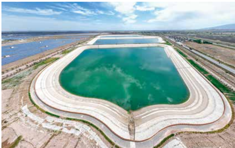
图 67 2024年4月,凉州区西营五千片区调蓄水池
