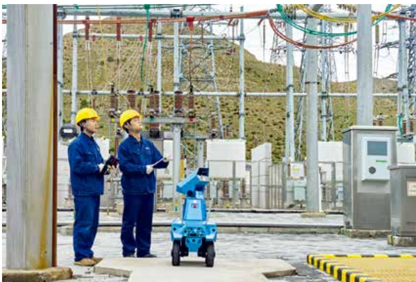
图 78 2024 年 10 月，330 千伏柏林变电站内变电运检中心员工开展巡视测温工作 (国网武威供电公司 供图)
