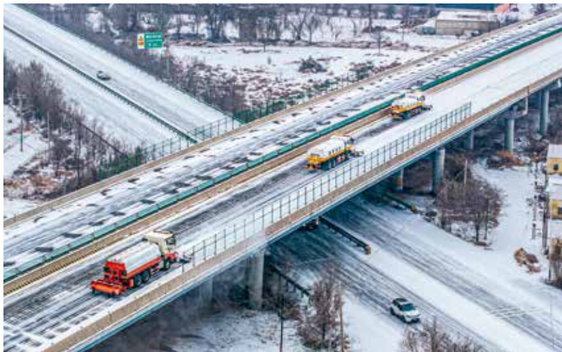
图 102 2024 年 12 月,北仙高速管理分公司开展管养路段除雪防滑和保通保畅工作 (杨再宏 摄)
