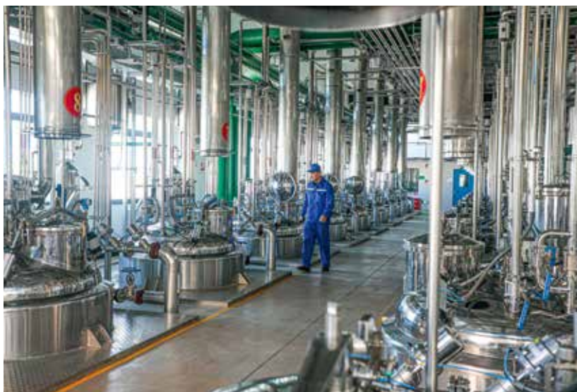
图77 2024年12月,甘肃普安制药股份有限公司液体制剂生产线升级改造项目提取车间一角 (王丽摄)
