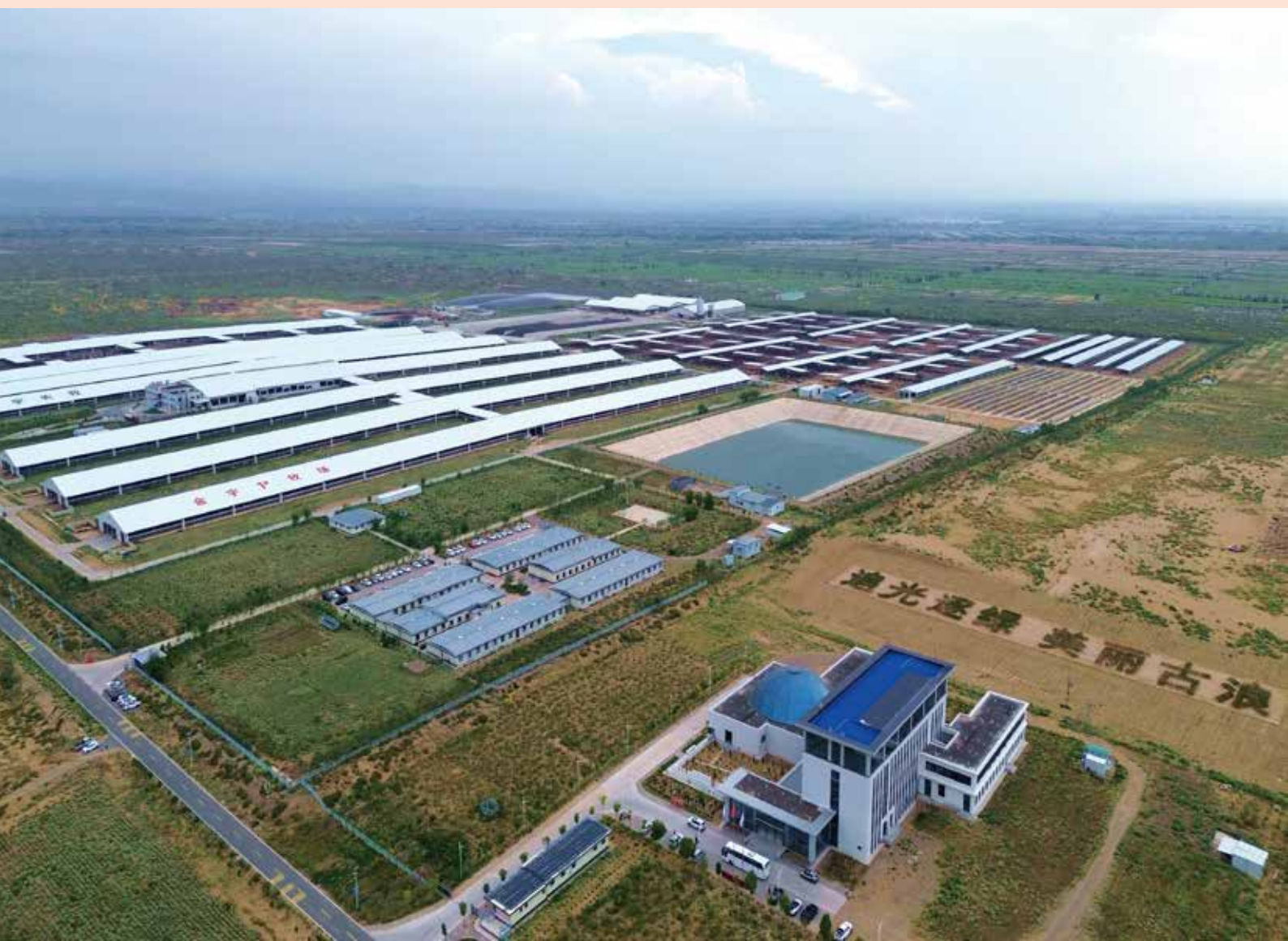
2024年9月,古浪县金字牧光互补产业园建设项目
