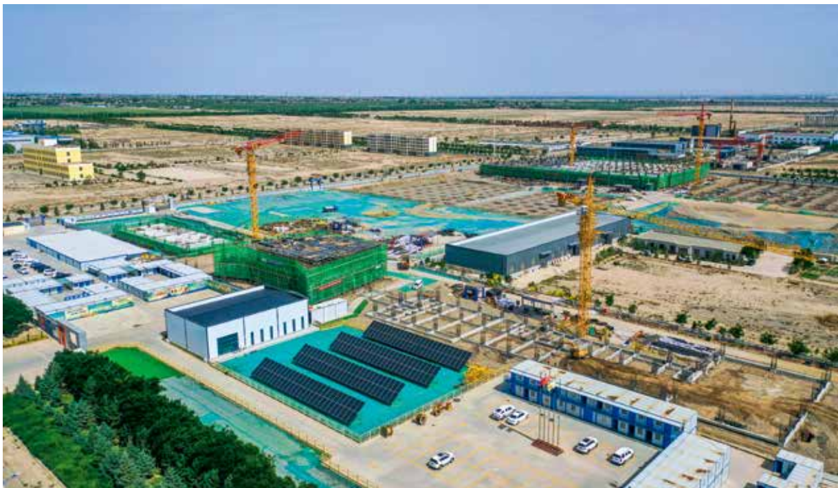
图 106 2024 年 5 月，稻盛云（武威）智算中心建设项目
