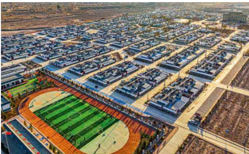
图 115 2024 年 6 月,凉州区金山镇生态及地质灾害避险搬迁安置点 (李政阳 王 舸 摄)
