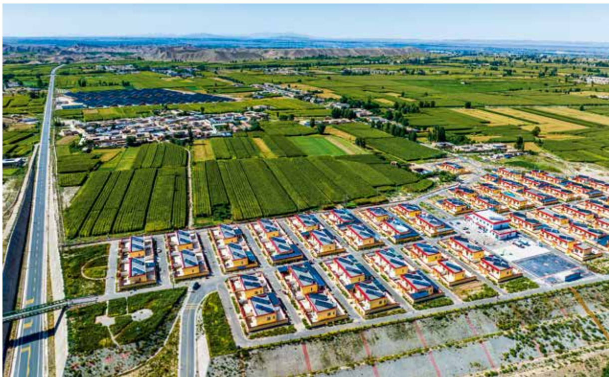
图 4 2024 年 8 月,凉州区康宁镇新寨生态及地质灾害避险搬迁安置点
