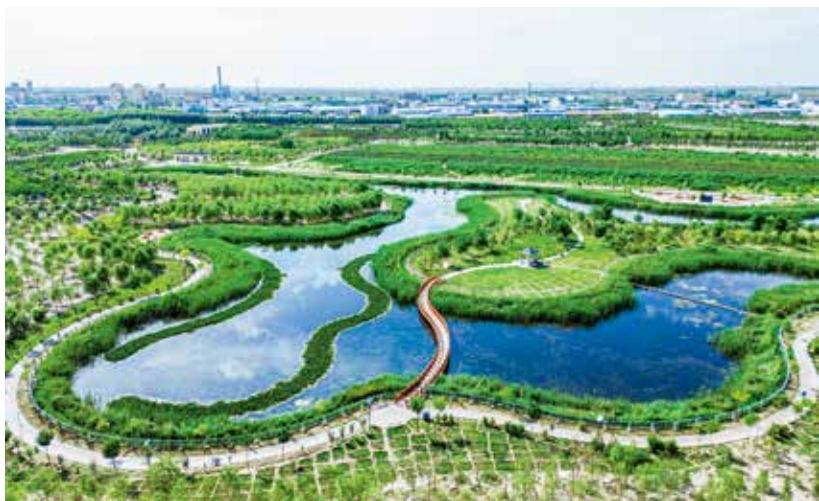
图 116 2024 年 7 月,民勤县污水处理厂生态湿地项目
