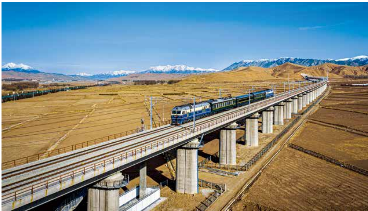
图 103 2024 年 3 月,兰张三四线铁路中川机场至武威段联调联试正式启动
