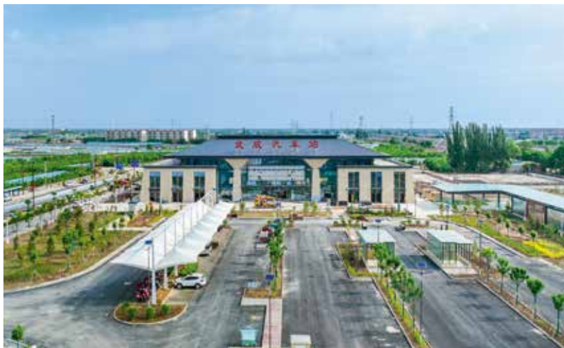
图 47 2024 年 6 月,武威东站综合客运枢纽及停车场项目 (韩筱蓓 高延锦 摄)
