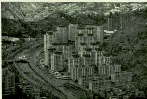
图 3:舟曲老城区新建的安置住房工程
