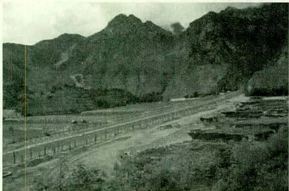
图 6: 舟曲三眼峪生态修复工程
