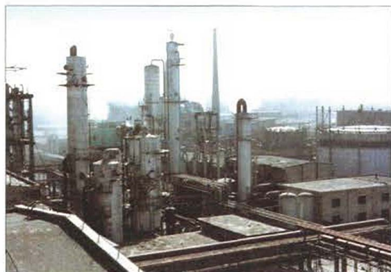
地区化肥厂一角
