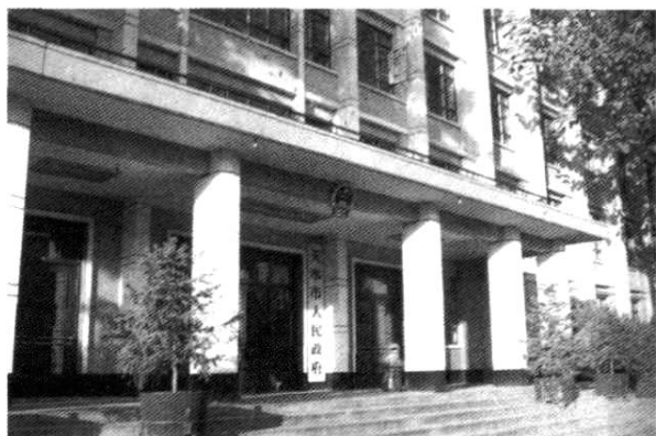
天水市人民政府办公楼
