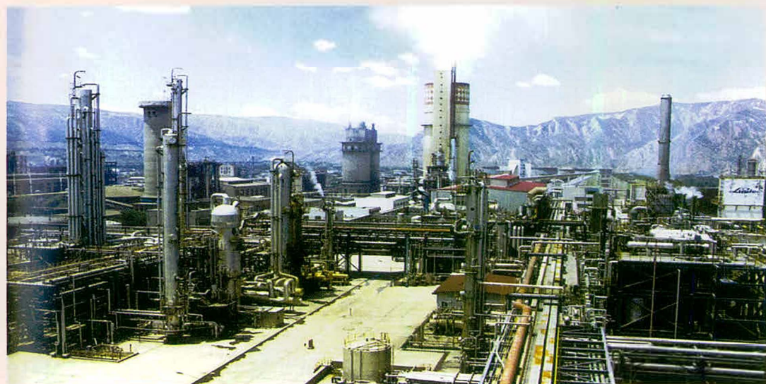
兰化公司大化肥生产装置
