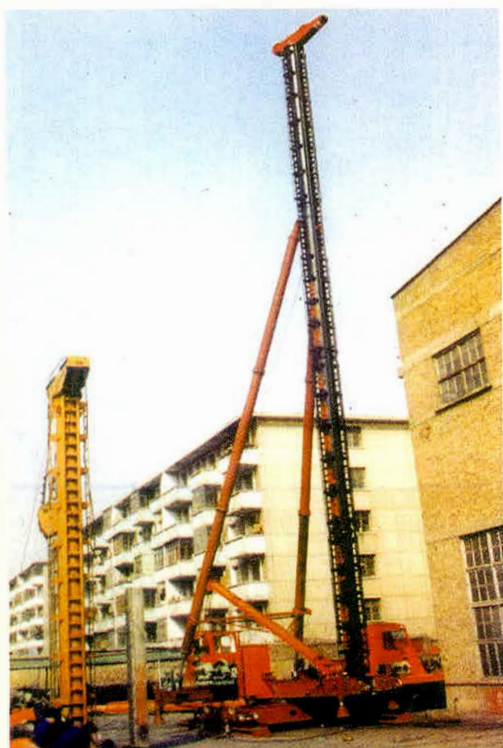
兰州建筑通用机械总厂生产的打桩机
