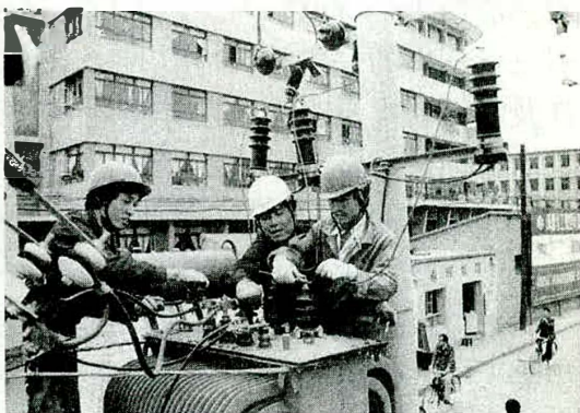
配电检修工人正在工作
