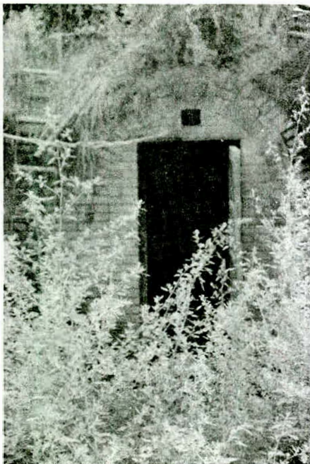
图17 抗日战争期间甘肃省会兰州防空司令部在五泉山武侯庙下构筑的防空工事 (1992年7月5日摄)
