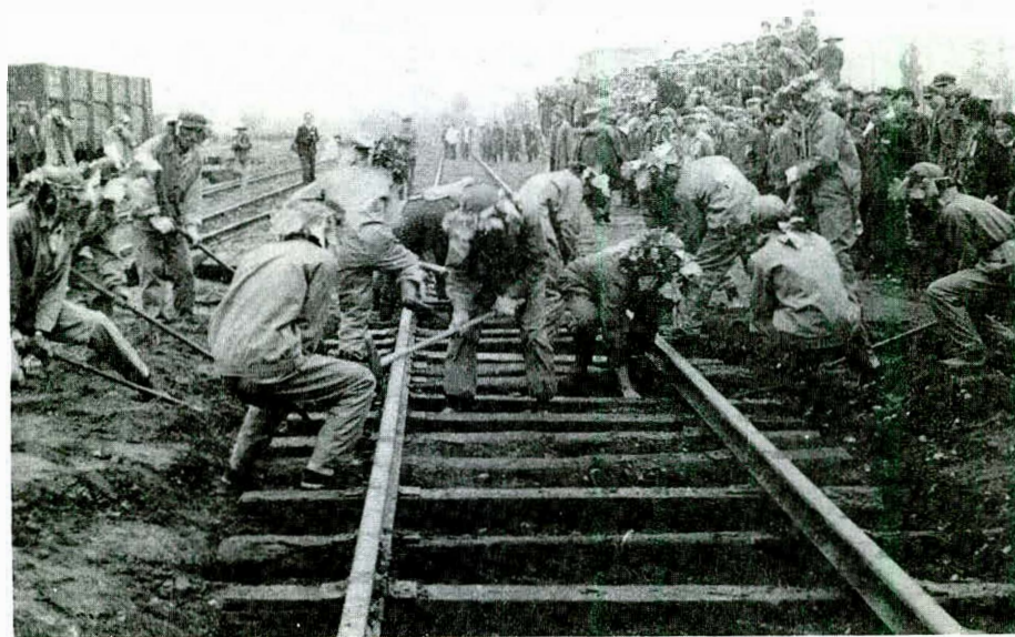
图 30 抢修被炸坏的铁路（1982 年 8 月 29 日摄）
