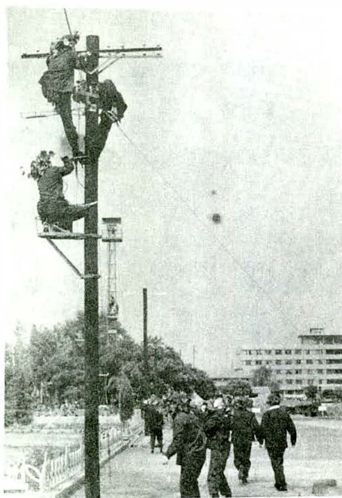
图 31 抢修被炸坏的通信线路（1982 年 8 月 29 日摄）
