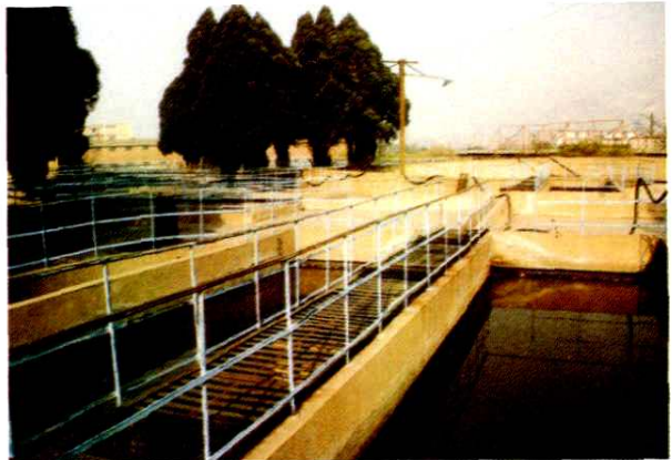
七里河污水处理厂一角
