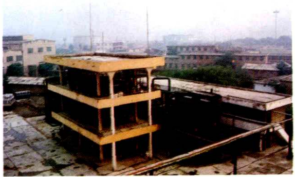
兰化化肥厂甲醇废水处理装置
