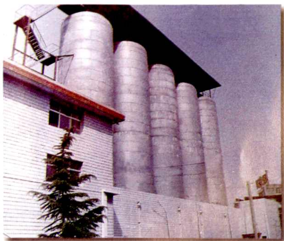
兰州岩棉制品厂保冷罐体
