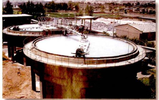
兰州水泥厂均化库
