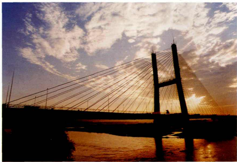
兰州第一座斜拉桥——银滩黄河大桥（2000年摄）
