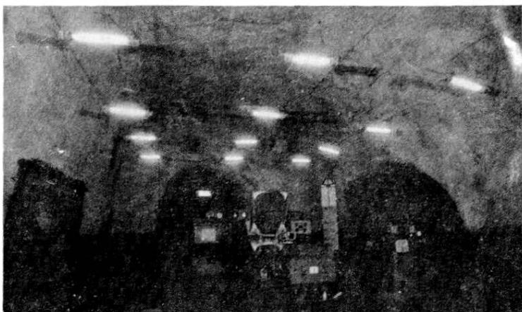
图 69 窑街矿务局 1 号平峒内部光爆锚喷支护 (1996 年摄)
