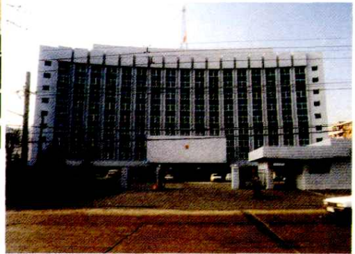
兰州市政府大楼(1996年摄)
