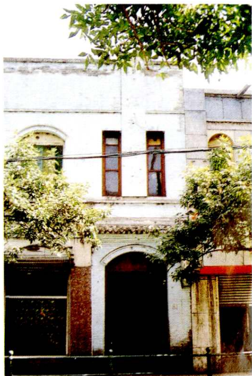
张掖路 81 号楼院大门
