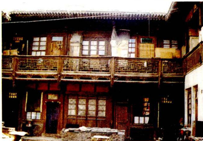
张掖路 81 号楼院上房、西厢房
