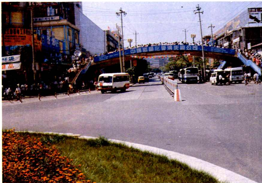
兰州铁路局广场西口 人行天桥 (1992 年摄)
