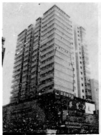
图 46 房建华富公司修建的高层商住楼（广武门）
