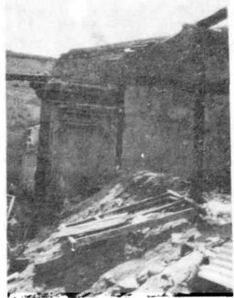
图21 1995年春节兰州市颜家沟住宅被火烧毁残迹
