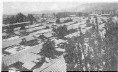
图 49 建于 50 年代的兰州建兰新村住宅区
