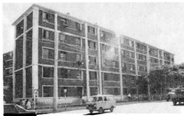
图 76 抗震加固楼（兰州市会馆巷楼区）（原小北门）
