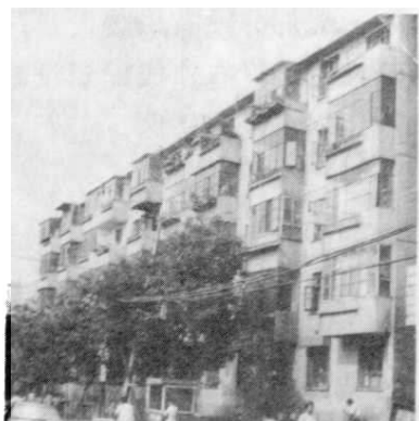
图 33 70 年代修建的大板楼 (小沟头楼区)
