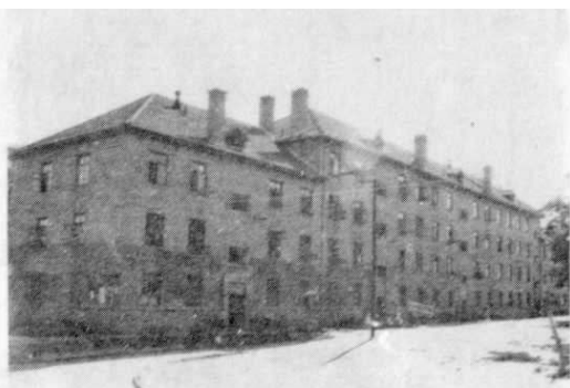
图 42 1959年修建的三、四层混合住宅楼（安宁万里厂住宅）
