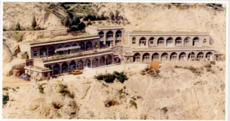
生土开发公司修建的窑洞 (兰州市城关区烧盐沟 45 号)
