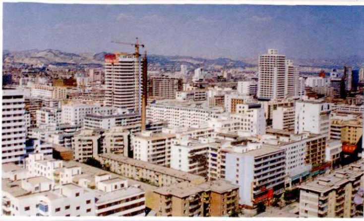
兰州市东市区西城巷旧城改造新貌
