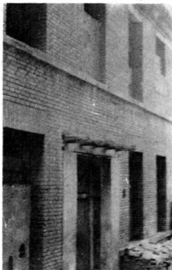
图 16 箭道巷兰州电报总局旧址，1947 年建造的电信楼
