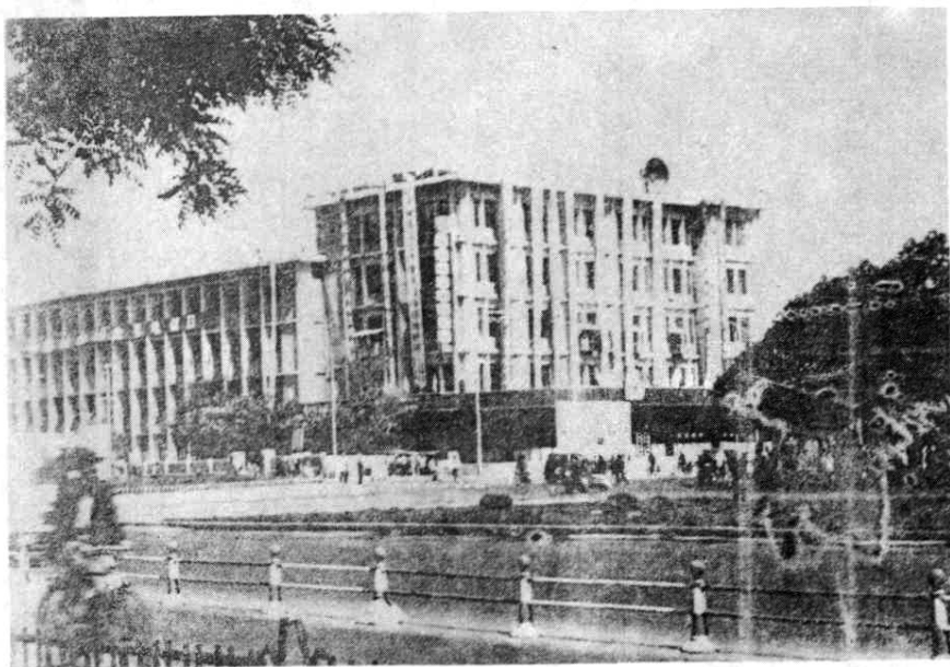
图19 1960年建成的庆阳路电信综合大楼
