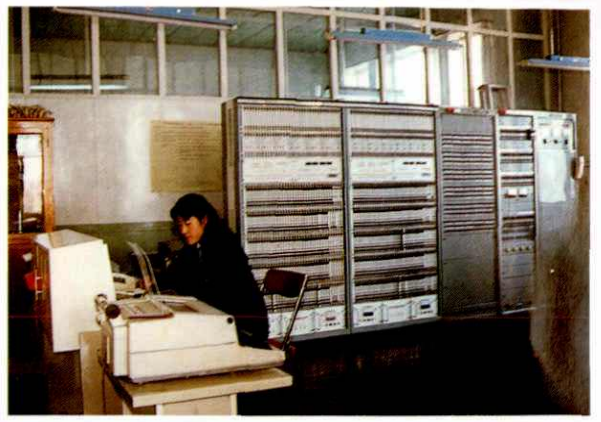
140线用户电报交换机房(1985年摄)
