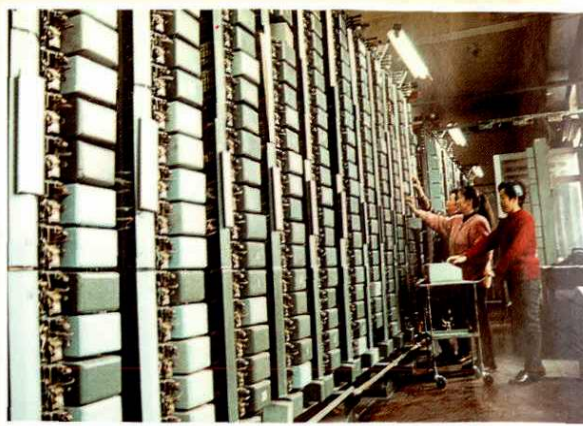
步进制交换机房(1985年摄)
