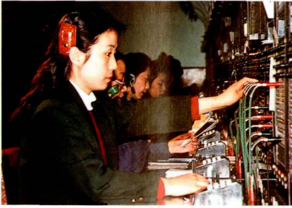
长途人工交换机房(1985年摄)
