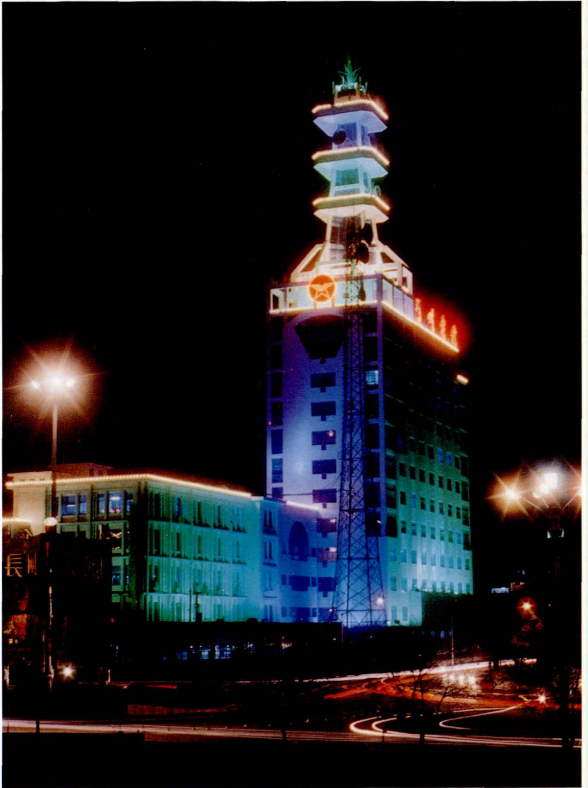
兰州电信枢纽大楼
