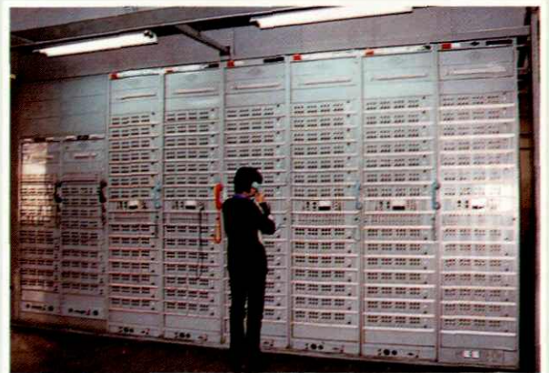
载波电话机房(1983年摄)
