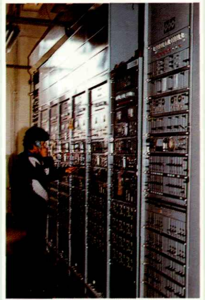
市内电话机房(1983年摄)
