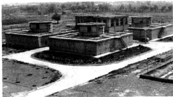
图 10 第二水厂加速澄清池（1985 年）
