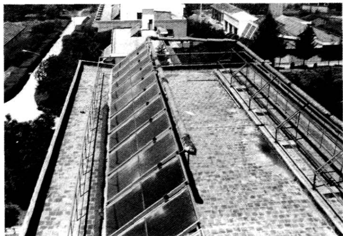
图 121 榆中县太阳能采暖试验基地
