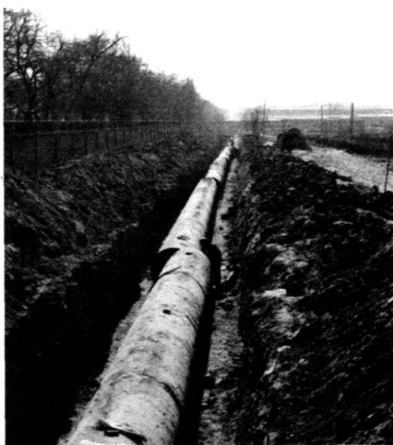
图24 西水东调一期工程 直径1200毫米干管在敷设(1984年)
