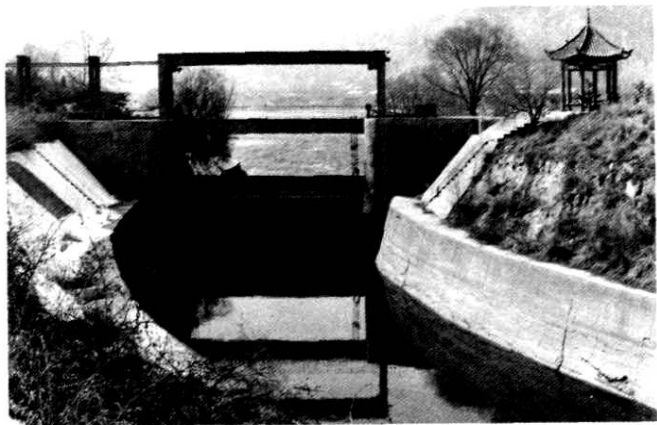
图 5 第一水厂上游取水口(2000 年摄)
