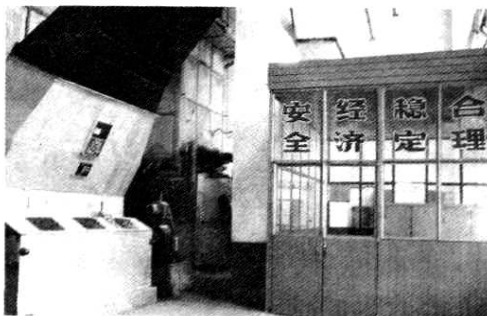
图114 王家庄供热站燃煤锅炉
