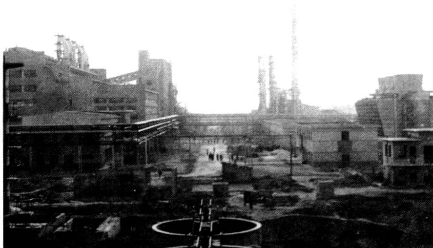
图 129 建设中的煤气厂
