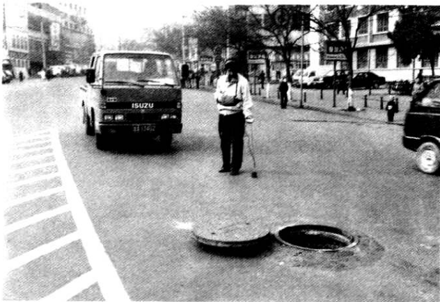
图 41 用水漏检测仪测漏
