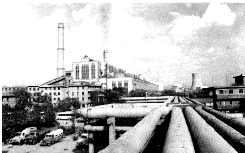
图 118 西固热电厂发电厂及供热管网
