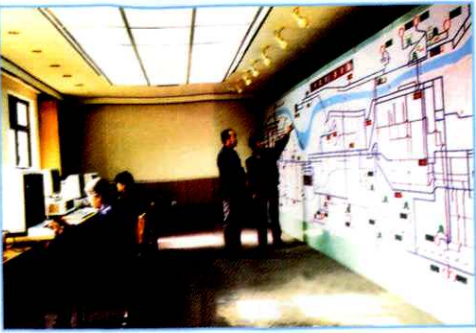
市自来水公司中心调度室城市供水管网压力遥测通讯计算机系统 (1990年摄)
