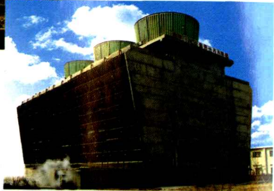
煤气厂循环净水塔(2000 年摄)
