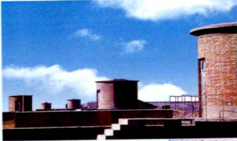
深井泵房(1984年摄)
