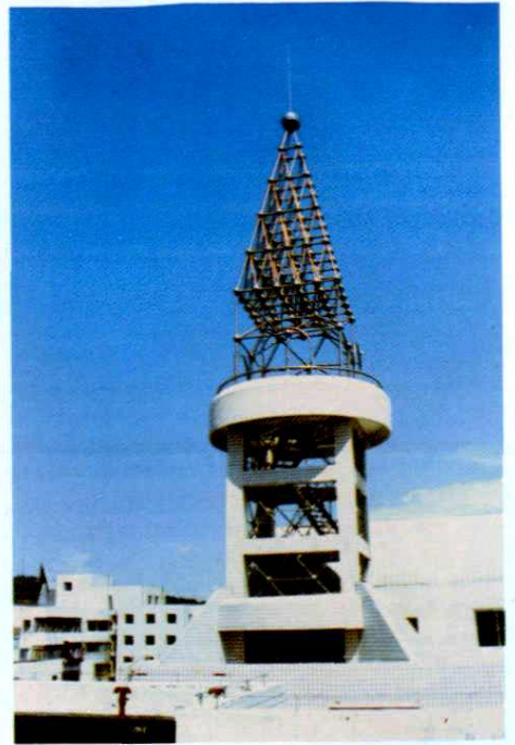
市公交总公司无线电系统电讯塔
