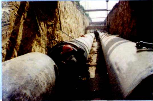
“二热”主管网施工现场
