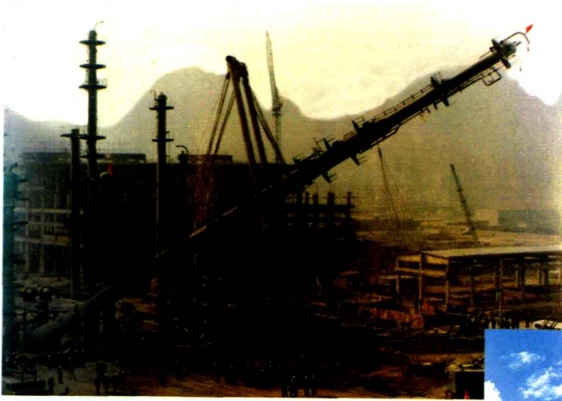
煤气厂 140 吸收塔吊装现场
