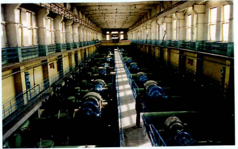
第二水厂2号二、三级泵房
