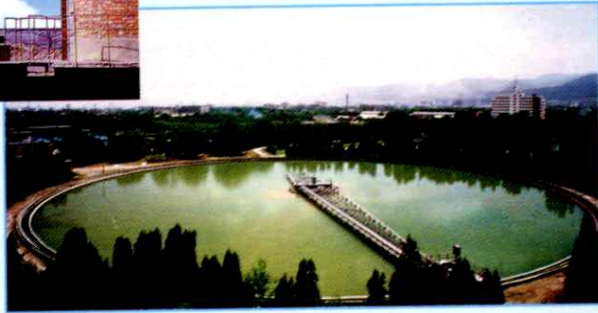
第二水厂沉 淀池(1994年摄)
