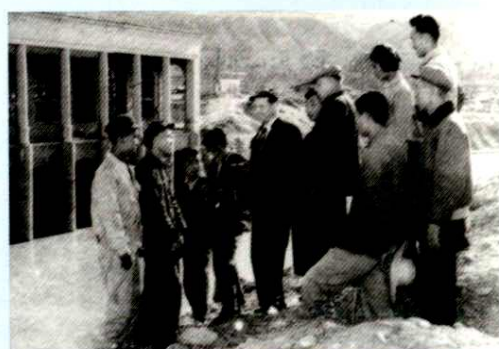
苏联专家在第一水厂施工工地(1955年摄)
