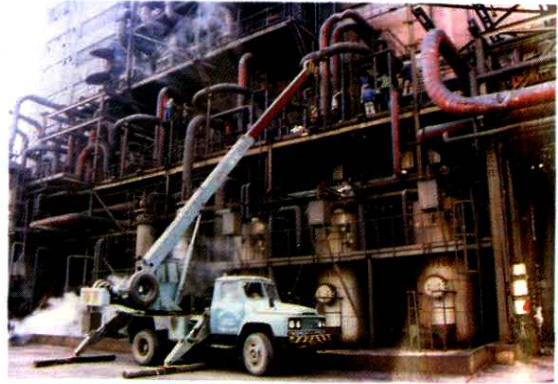
煤气厂 气化学装置 试车
