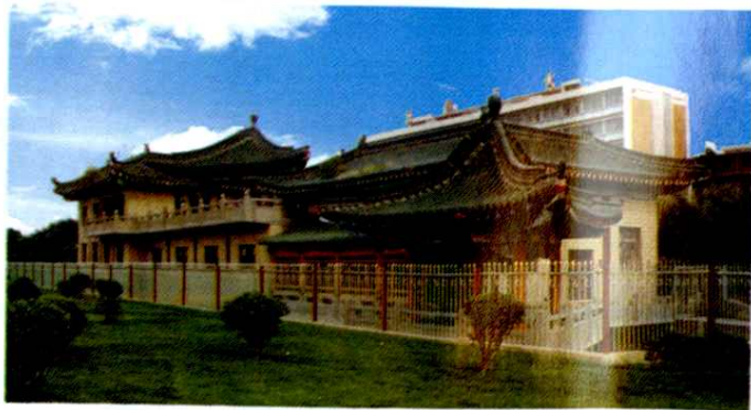
滨河路电车整流站外景
