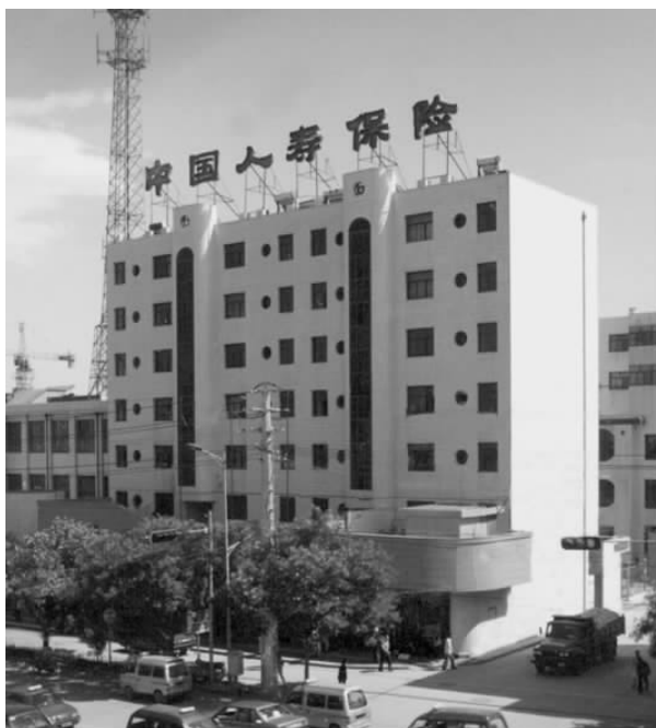
平凉人寿保险公司办公楼
