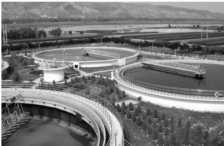
平凉市给排水公司供水沉淀池
