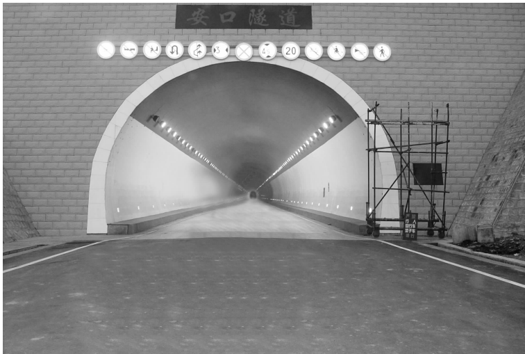
华亭安口隧道
