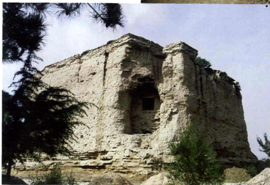
抗日战争时期， 甘肃全省防空司 令部在皋兰山修筑的 瞭望台。
