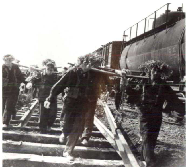
兰州市人防专业队在防空袭演习中，演习抢修“被炸”铁路。
