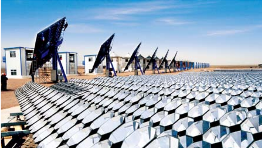
新型光伏发电阵列
