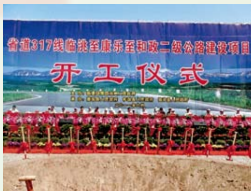
公路建设——临康和二级公路开工
