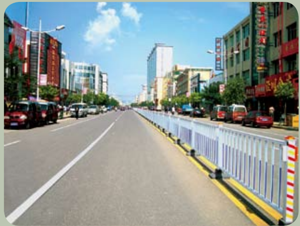
县城街路改造工程
