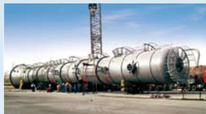
烯烃项目热再生塔
