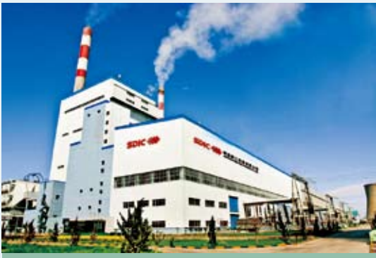
靖远二电生产主厂房外景
