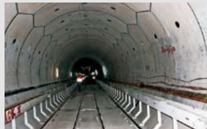
衬砌成型的引洮工程总干渠9号隧洞
