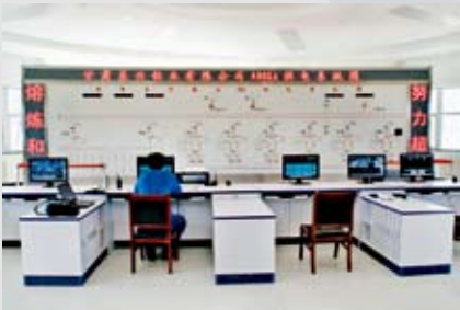
现代化的动力整流所数字主控室
