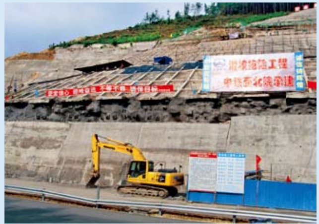
承建的重庆市渝湘路D3标滑坡应急抢险工程
