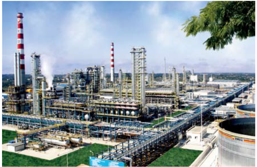
中国石油庆阳石化公司生产区一角
