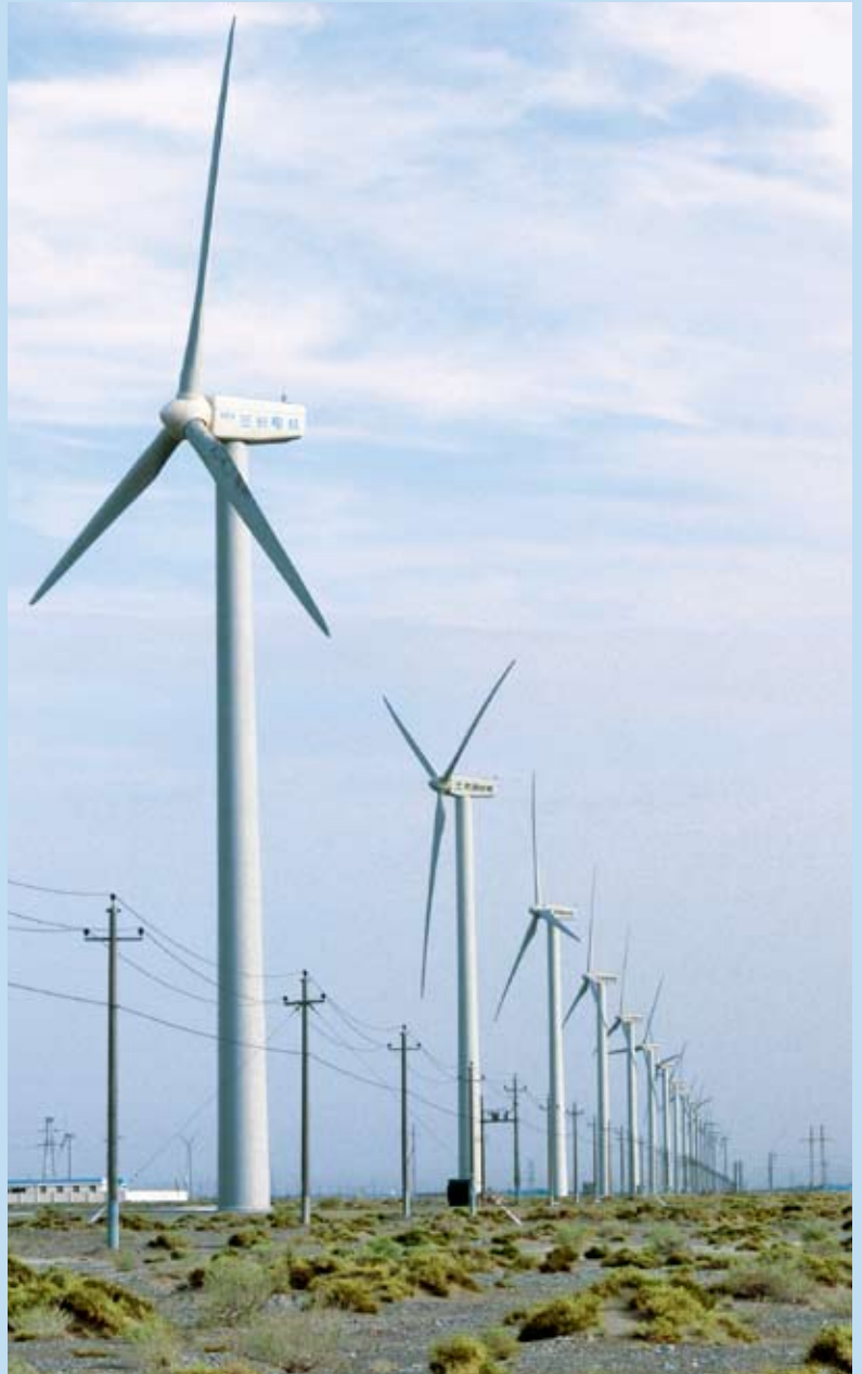
兰州电机兆瓦级风力发电机组在玉门运行
