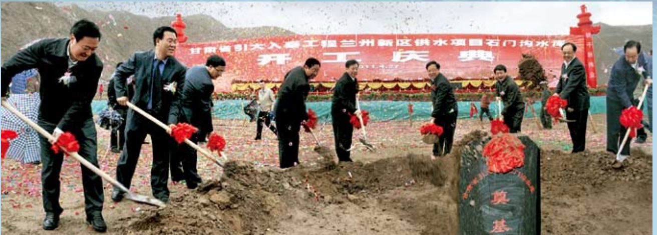
引大入秦工程兰州新区供水项目石门沟水库于2011年4月27日开工建设，该项目的开工建设，标志着兰州新区供水基础设施项目建设迈出了坚实的步伐
