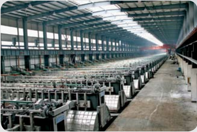
甘肃东兴铝业陇西分公司400KA电解槽
