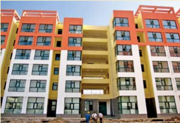
龙泰集团公司参与建设的榆钢职工公寓楼
