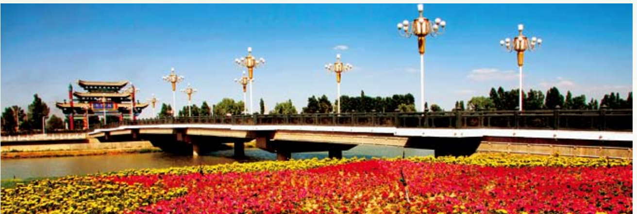
大沙河流域综合治理一、二期工程
