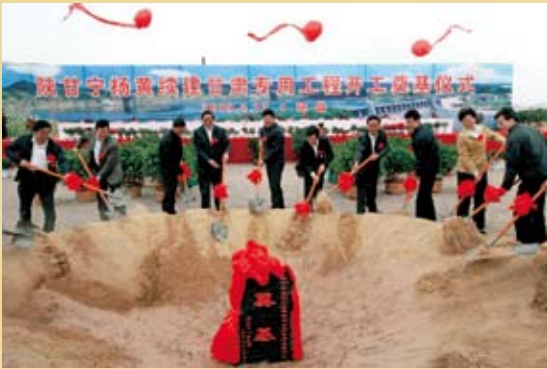
扬黄工程二期开工奠基
