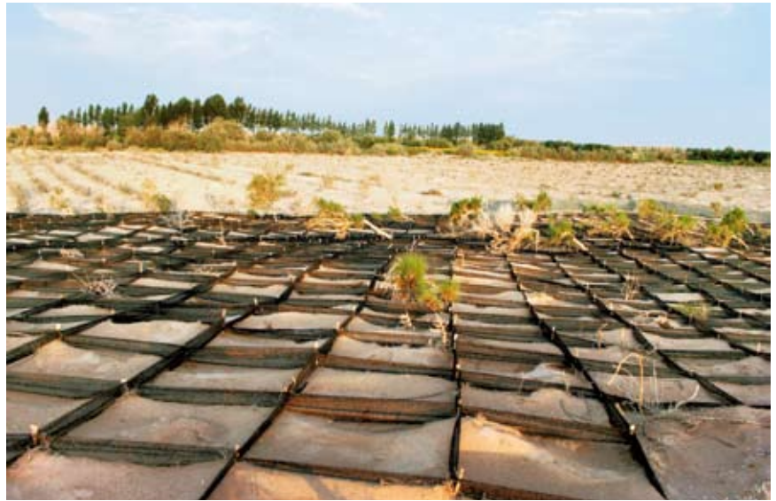
实施三北防护林建设工程中,省治沙所民勤治沙站试验推广的新型沙障
