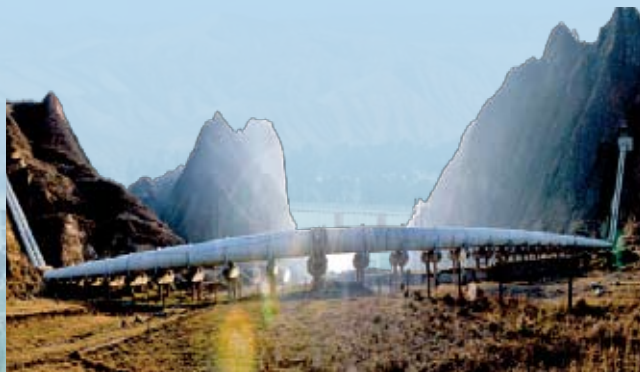
工作水头107米的引大入秦工程总干渠先明峡倒虹吸，建成时位居亚洲第一
