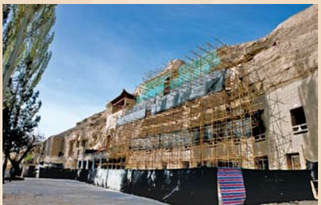
莫高窟南区加固工程
