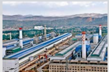
东兴铝业陇西分公司主厂区俯瞰图
