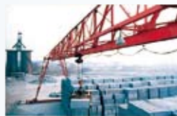
加气混凝土砌块成品库现场
