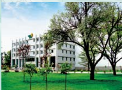
兰州所国内规模最大的疫苗生产综合设施
