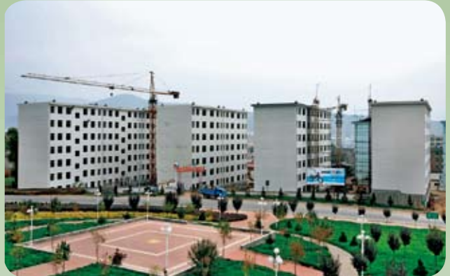
建设中的北城区廉租住房
