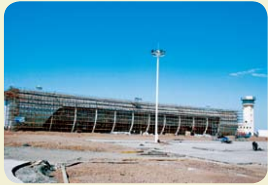
建设中的金昌机场候机楼
