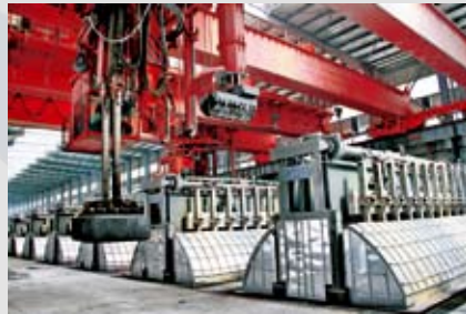
工人驾驶多功能天车正在进行阳极提升作业
