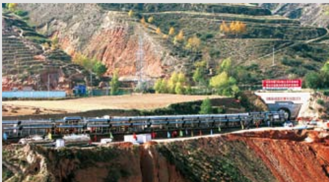
引洮7#隧洞TBM掘进机
