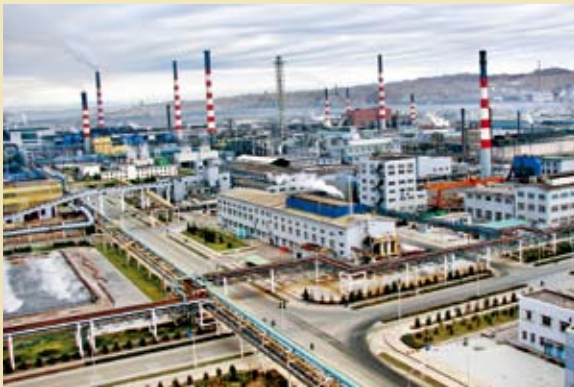
工业新厂区建设
