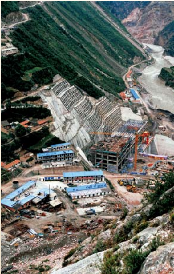
引洮水利枢纽工程建设工地
