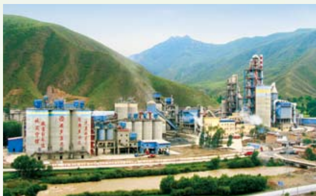
夏河县安多集团厂区
