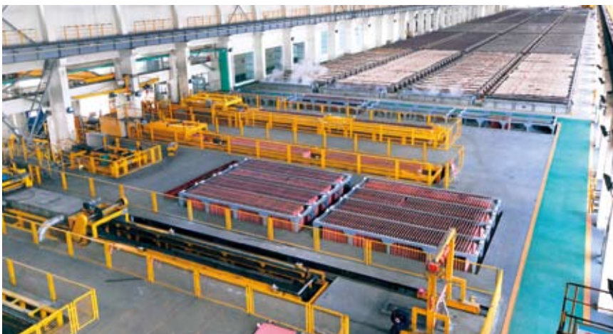
白银有色集团公司铜业公司20万吨阴极铜生产车间
