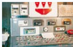
加气生产线浇注工序配料控制台
