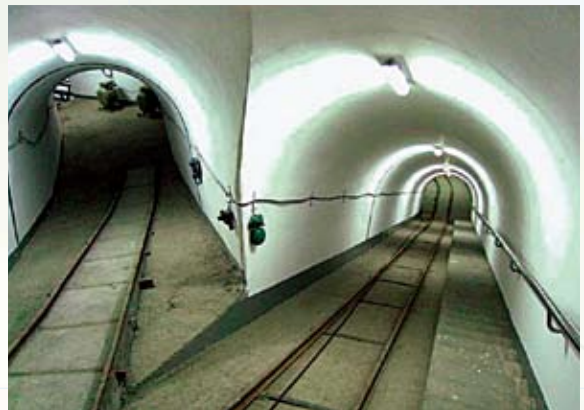
现代化仿真矿井
