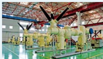
长城电工长开厂公司生产的高、中、低压开关设备远销国内外46个国家和地区
