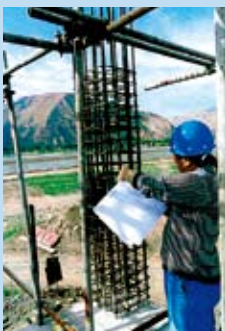
天定高速公路房建工程现场监理检查钢筋
