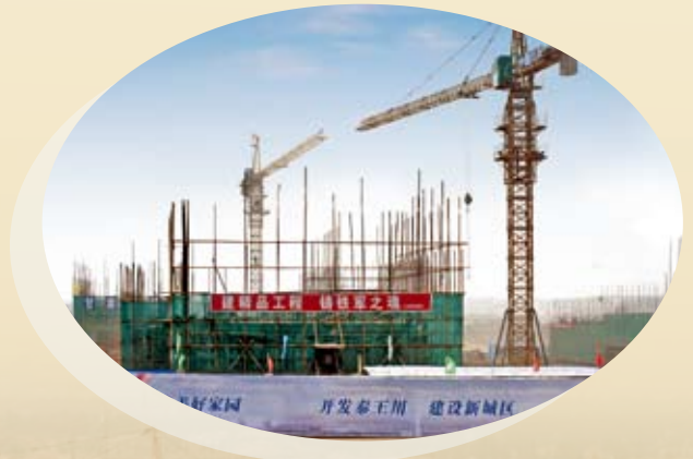
兰州新区舟曲转移安置区项目施工现场
