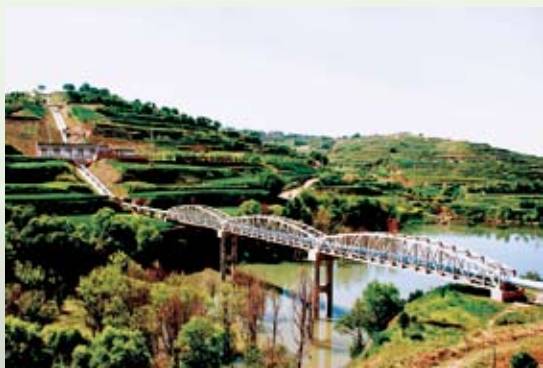
南阳渠倒虹管
