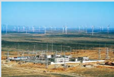
世界首座专为风电场设计的北大桥东330KV 变电站
