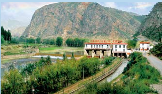
引大入秦工程渠首引水枢纽
