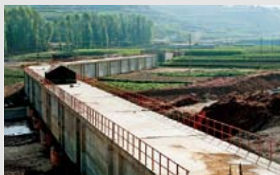
引洮总干渠3#-4#隧洞连接段工程
