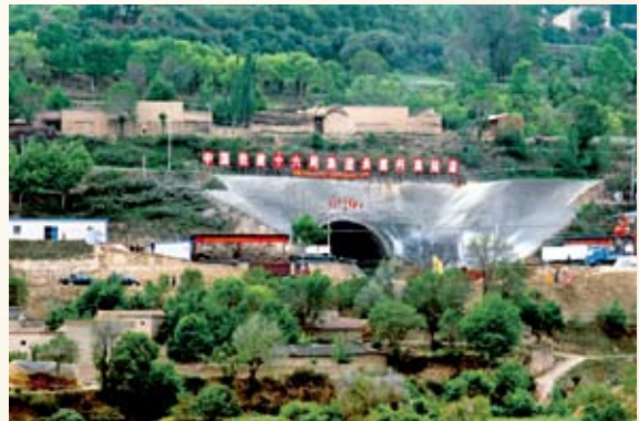
兰渝铁路施工现场
