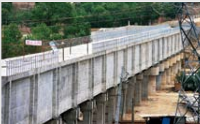
引洮总干渠定西安定区阳阴峡渡槽
