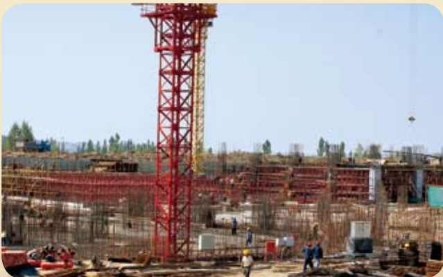
兰州新区综合服务中心施工现场
