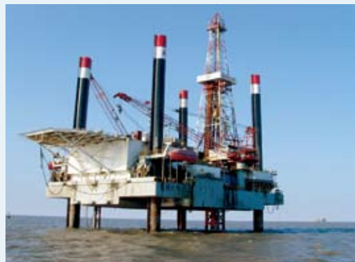
长城电工天传所公司为国内海洋平台设计的控制系统在渤海运行
