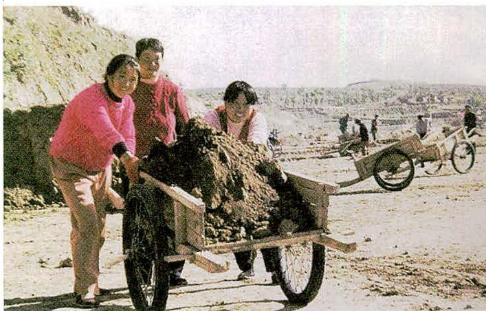
梯田建设现场
