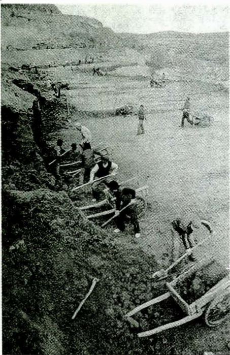
梯田建设现场
