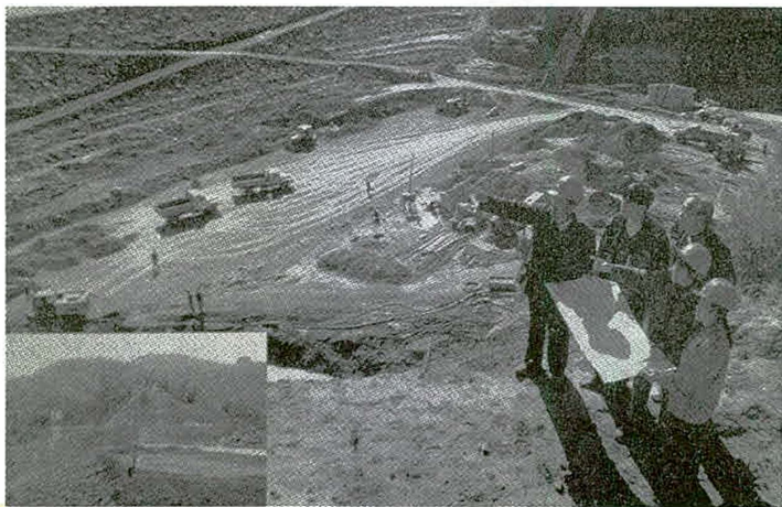
梯田建设现场
