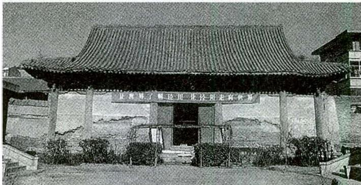
安装了木雕隔屏，以屏代幕，将舞台分成前台和后台。后台背面留3个方窗，两侧各留一门道通乐楼。楼下中间为出入通道，其两侧只留门窗，四面为墙，又在文武场面后背置上下楼梯。紧贴戏台背面又建有半个与戏楼连体的背部造型。前后斗拱、额坊、垫板、椽头以及欢门牙子，均以朱漆彩绘。
