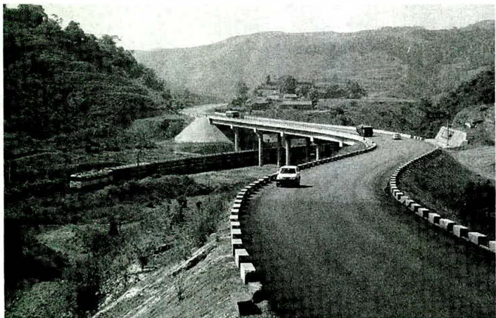
公路铁路交通四通八达
